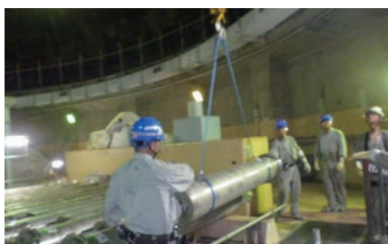
制御棒駆動装置の移動
