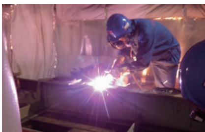
プラズマ溶断作業
