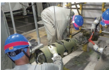
制御棒駆動装置モーター部の分解
