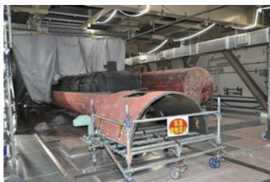
給水加熱器の解体
