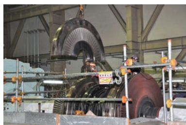
タービンの解体
