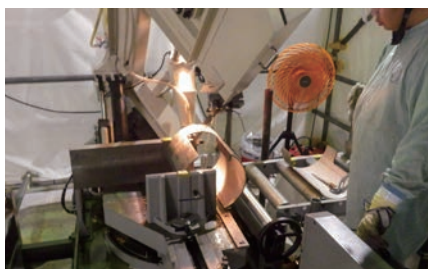
大型バンドソーを用いた切断作業
